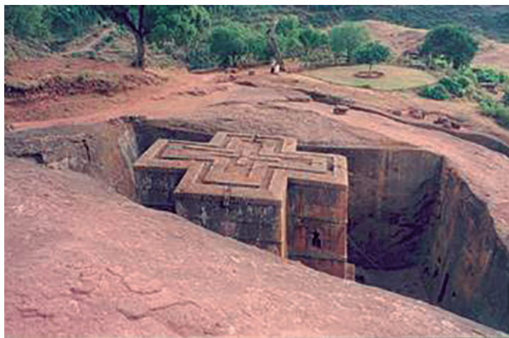
Figura 1. Iglesia etíope excavada en la roca (siglo XII) © 3coma14 / CC-BY-SA-2.0.
